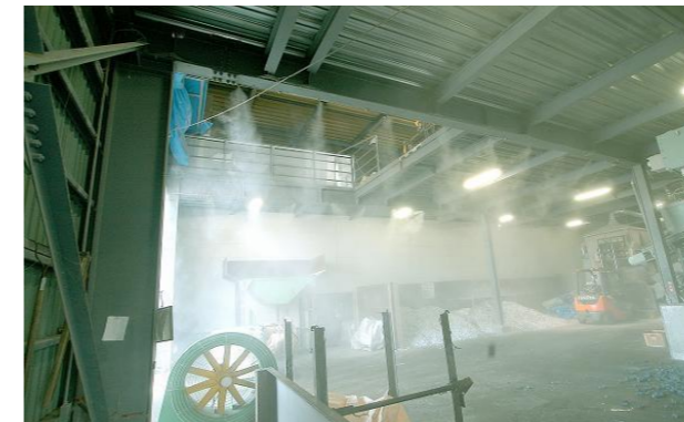
産廃処理工場内部
